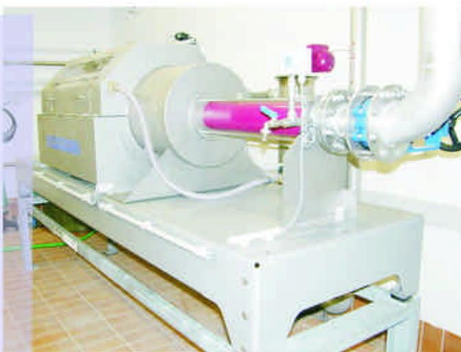
Der im Reaktor nach der Abwasserbelebung und Belüftung abgesetzte Schlamm wird zum Teil als Überschussschlamm zunächst in den Schlammvorlagebehälter gepumpt (den ehemaligen Tropfkörper).
