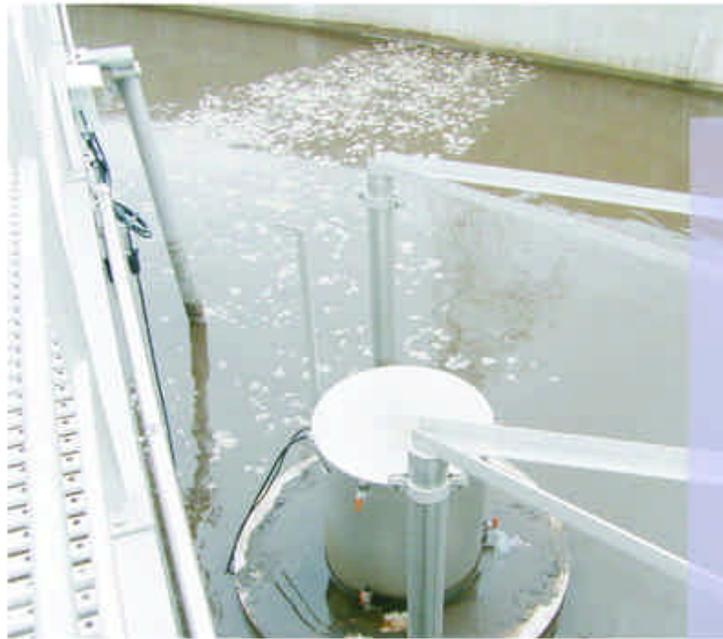
Blick über den Dekanter in ein volles Reaktorbecken während der Belüftung
